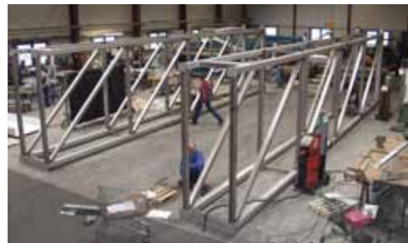
Große Gestelle für Brückenfachwerk
